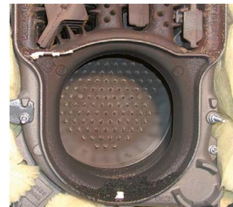
Chambre de combustion d'une chaudière après 1800 heures de fonctionnement au mazout Eco pauvre en soufre.
